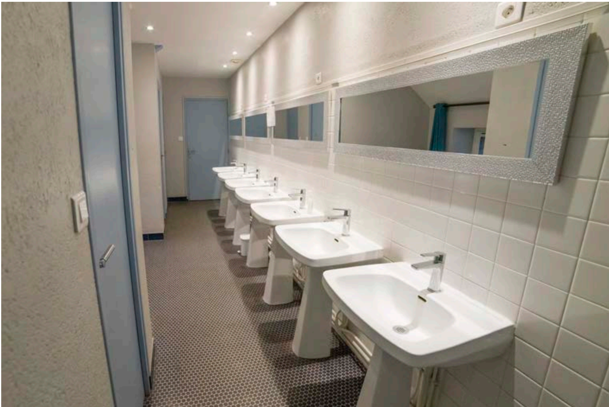
Salle de bains La Pervençère.
